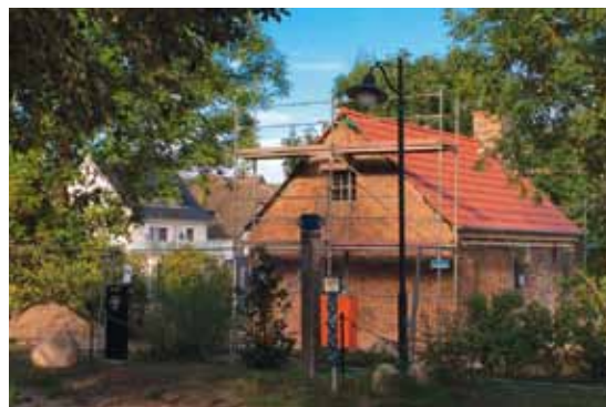
Die Alte Schmiede erhielt während der Sanierung auch ein neues Dach. Foto: Heiko Björn Gustavs
