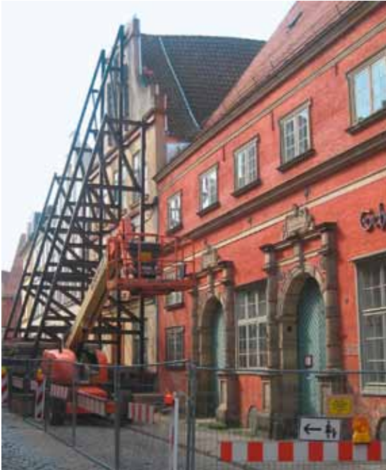
Museumsbaustelle Schweinsbrücke 6 und 8. Foto: Stadtgeschichtliches Museum Wismar, 2012
