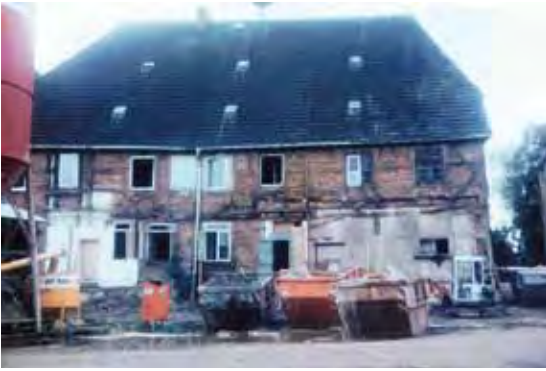
Rückseite der ehemaligen Wassermühle während der Sanierung 2001. Foto: Archiv Kunstmuseum Schwaan
