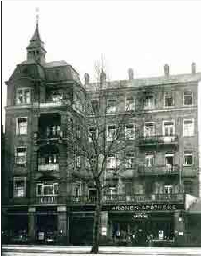
Die von Apotheker C. Stephan erweiterte Kronen-Apotheke nach Fertigstellung im Jahr 1908 Bilder und Dokumente © APOGEPHA Arzneimittel GmbH
