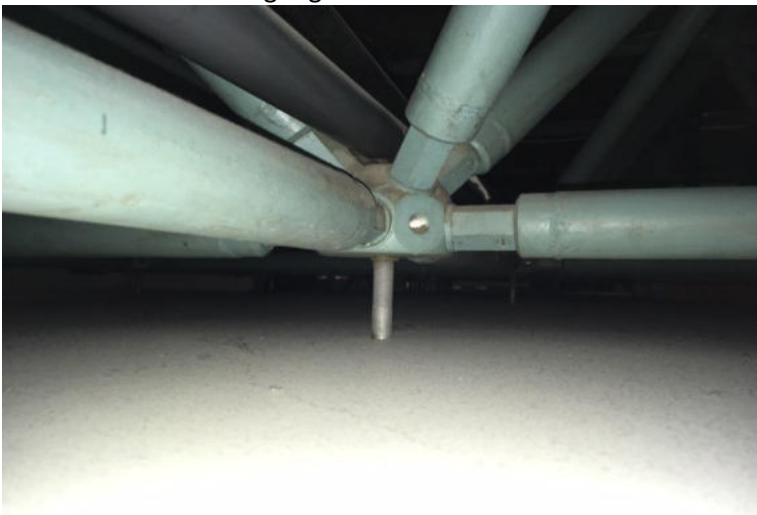
Vitrinendeckelbefestigung am Stabwerk
